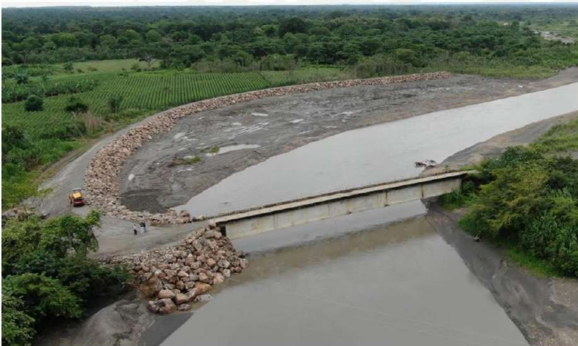
Fotografía. Reforzamiento del puente en la margen derecha del río Cravo Sur - obra culminada.
