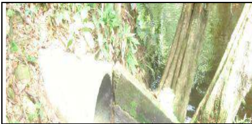
Vertimiento sobre la Quebrada la Pava
