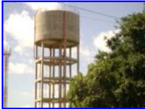
Fotografía 3. Tanque de Almacenamiento en concreto reforzado
