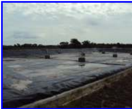
Fotografías 7 y 8. Celda debidamente impermeabilizada con geomembrana y estructuras de evacuación de gases y lixiviados.
