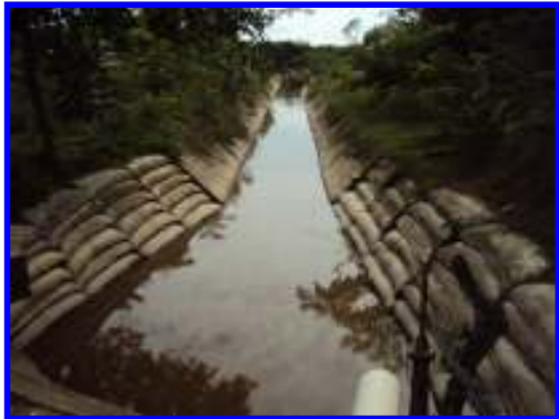
Fotografías 11 y 12. Canales colectores construidos para la recolección y evacuación de las aguas lluvias del área urbana del Municipio de Puerto Rondón.
