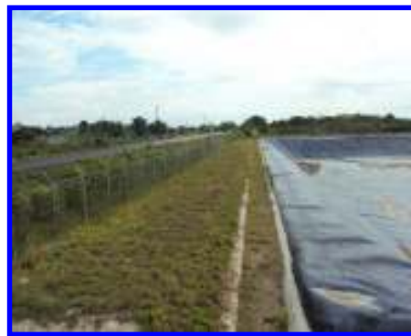
Fotografías 7 y 8. Celda debidamente impermeabilizada con geomembrana y estructuras de evacuación de gases y lixiviados.
