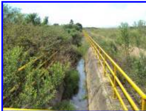
Fotografías 11 y 12. Canales colectores construidos para la recolección y evacuación de las aguas lluvias del área urbana del Municipio de Puerto Rondón.
