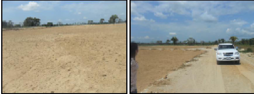
Fotos 6-7. Construcción relleno sanitario regional
