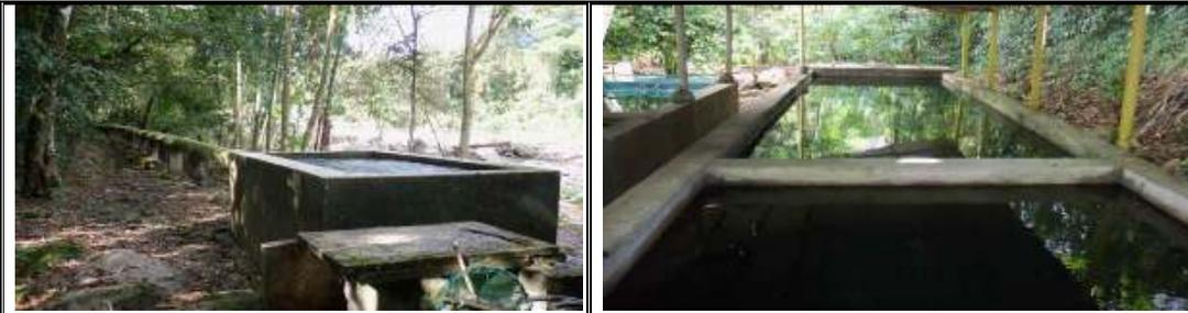
Foto No. 6 Tanque de quietamiento y estructura de desarenadores del acueducto del municipio de Fortul.
